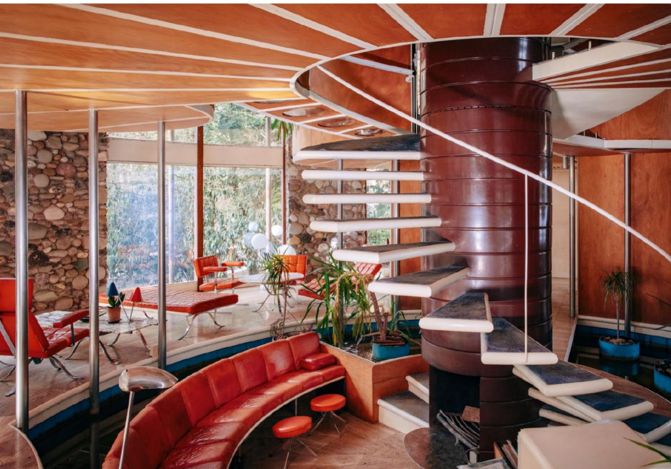
Die Stahlspindeltreppe bildet die tragende Achse des Gebäudes. Sie gehört zu Otto Kolbs wichtigsten Erfindungen
